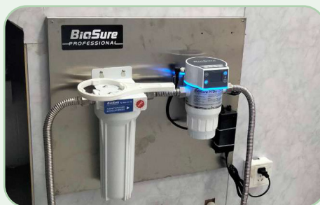
Manutenzione preventiva delle condutture dell'acqua
