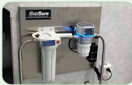
Mantenimiento preventivo de tuberías de agua
